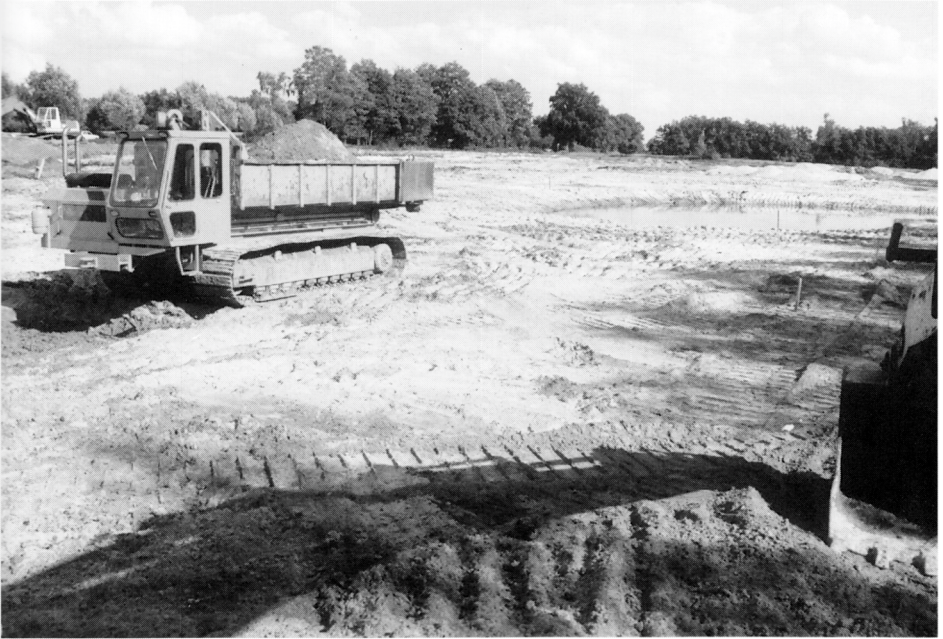
Abb. 140 Bauarbeiten im Steinhorster Becken.
